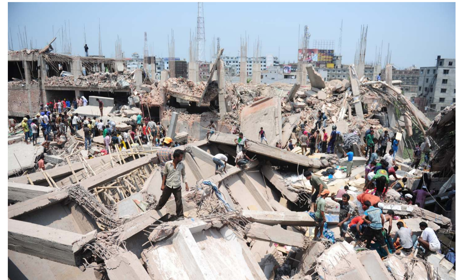
Savar (Bangladesh), le 24 avril 2013. Dans ce faubourg de Dacca, le bâtiment Rana Plaza, qui abritait plusieurs ateliers de confection travaillant pour des marques internationales de vêtements, s'est effondré le matin. 1 138 travailleurs du textile ont trouvé la mort. (AFP/Muriz uz Zaman.)
